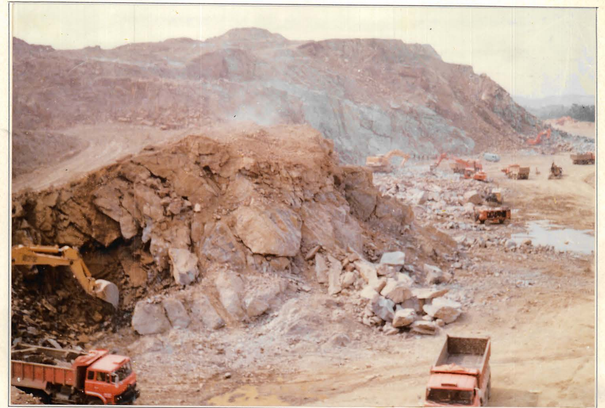
土石採取現場 (2,000 坪 (226 畝))
