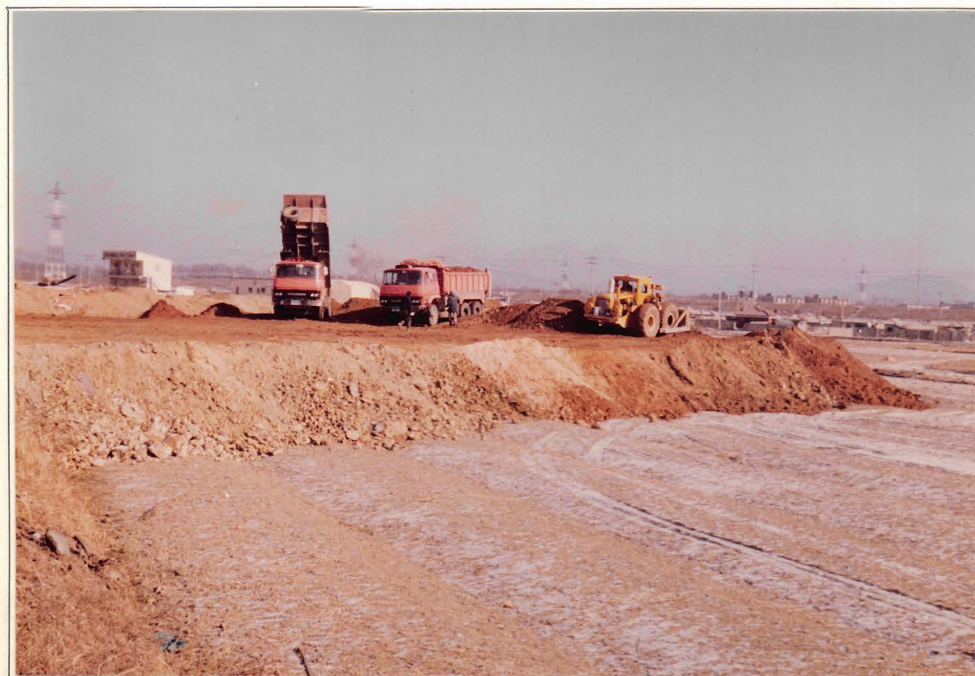
敷地造成全景
