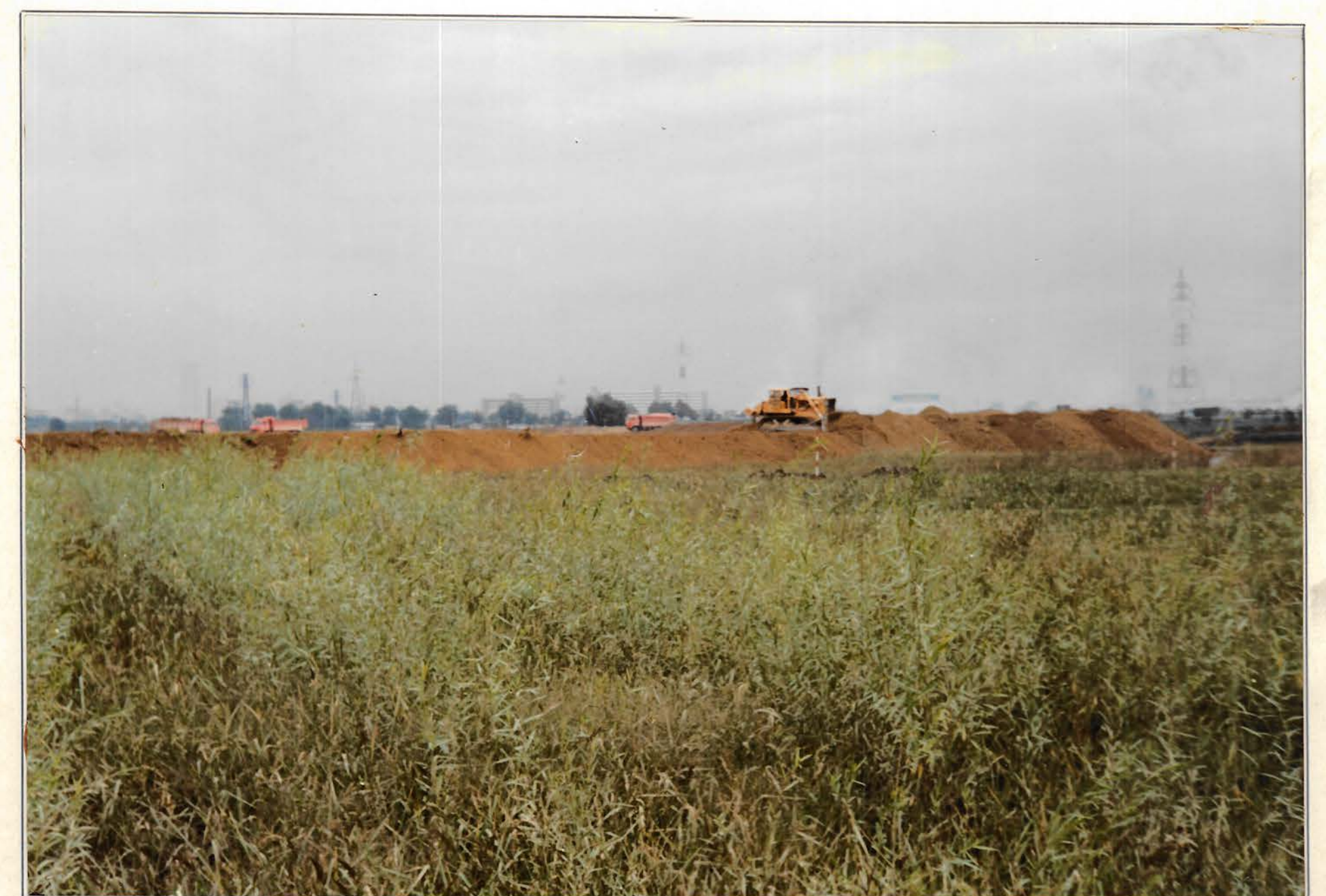
敷地造成全景
