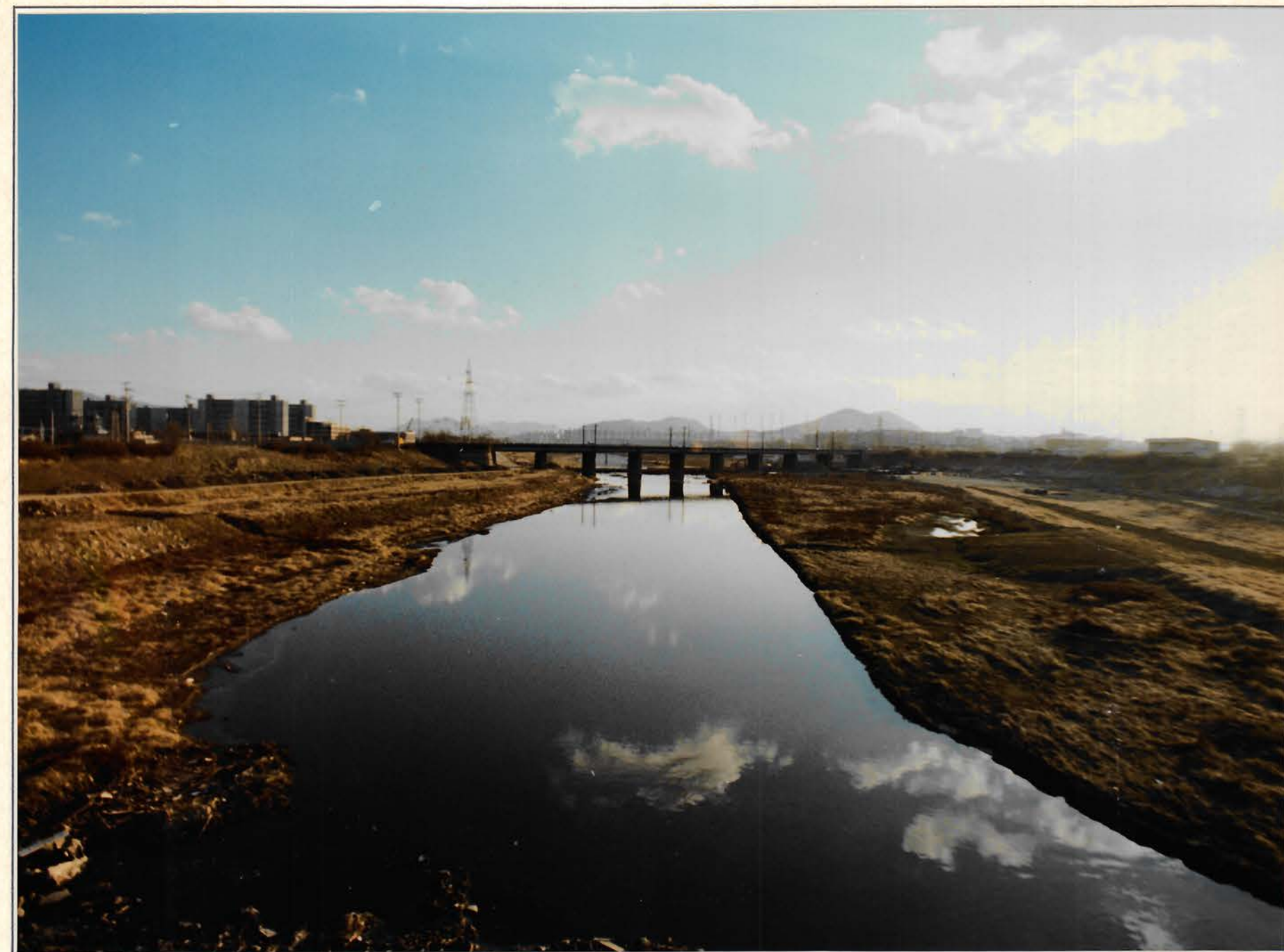
安養川整備前
